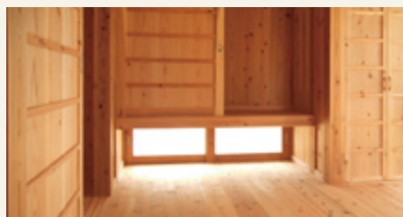
⑤ 換気と採光ができる収納下の地窓
